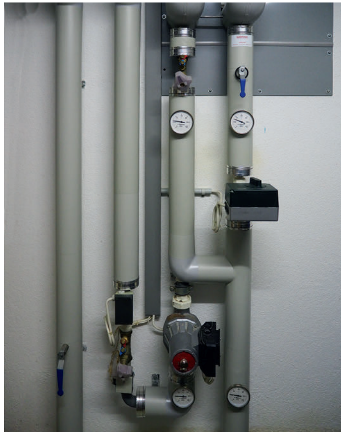
Die Heizungsunterstation des Kindergartens 2
