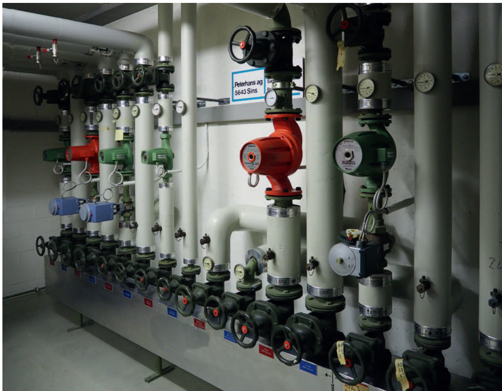
Die Heizungsunterstation für die Mehrzweckhalle und das Gemeindehaus
