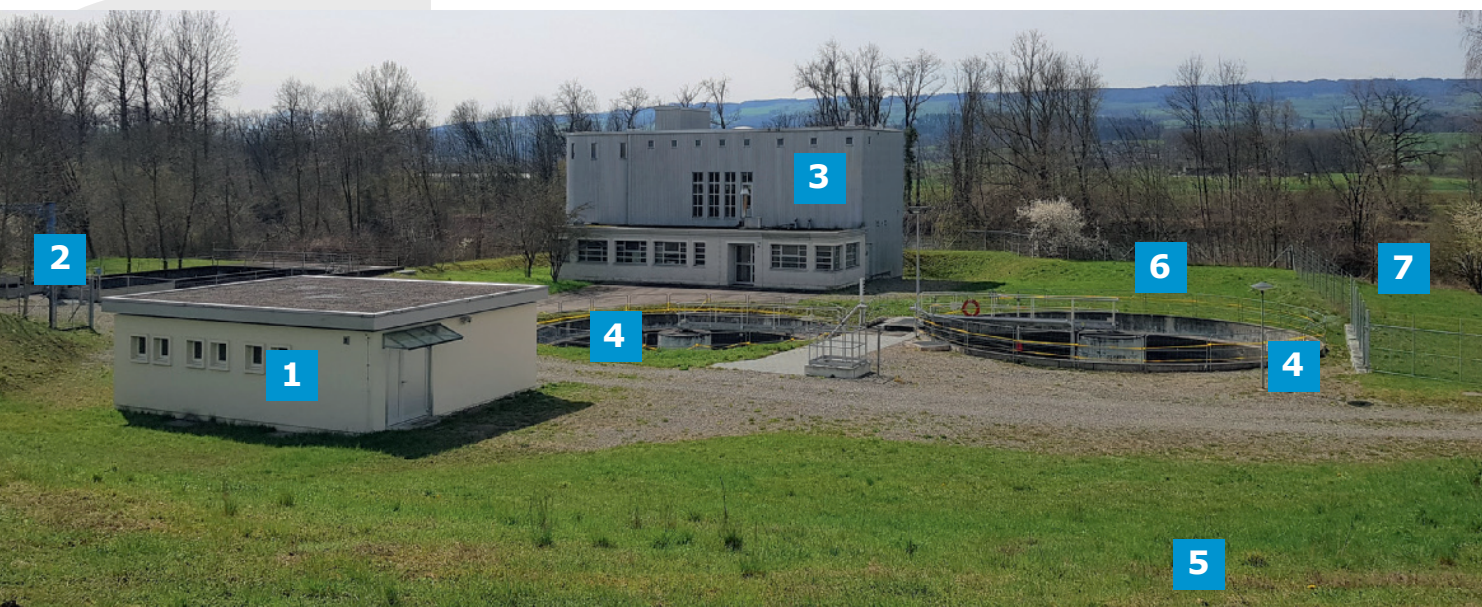
Das ARA-Gelände im März 2023 nach dem erfolgten Rückbau und der Umnutzung
