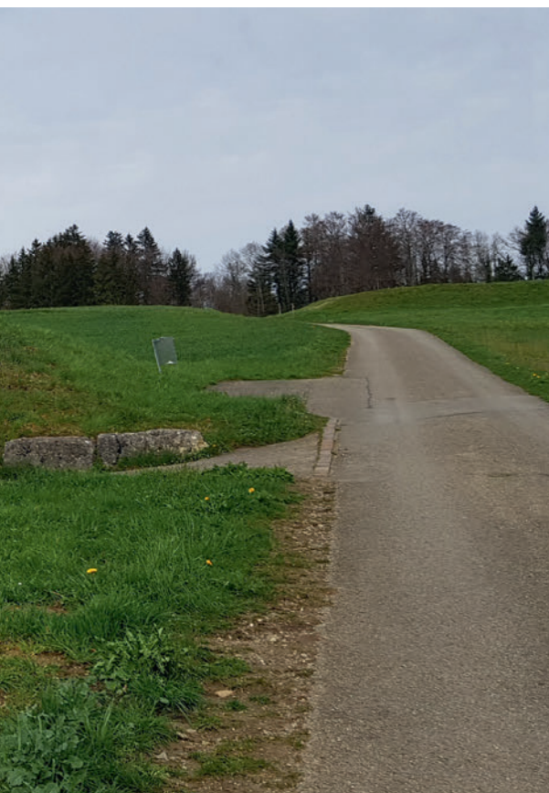
Das Reservoir Dorf am Sonnenberg mit Baujahr 1959
