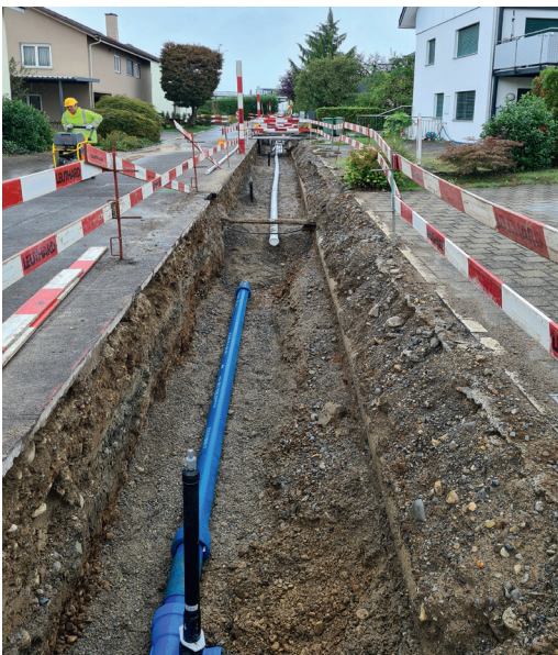
▲ Rohrlegearbeiten im September 2024
